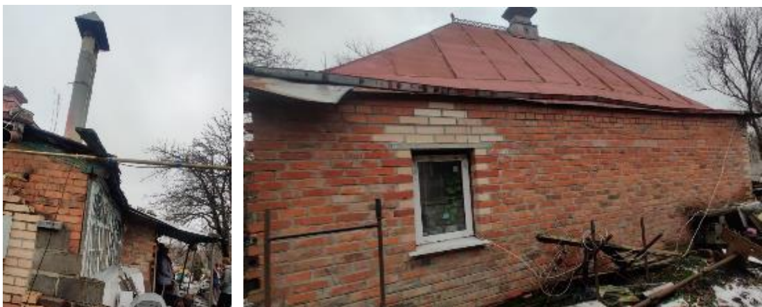
Рисунок 3 - Пічні труби та залізний дах сучасного будинку
